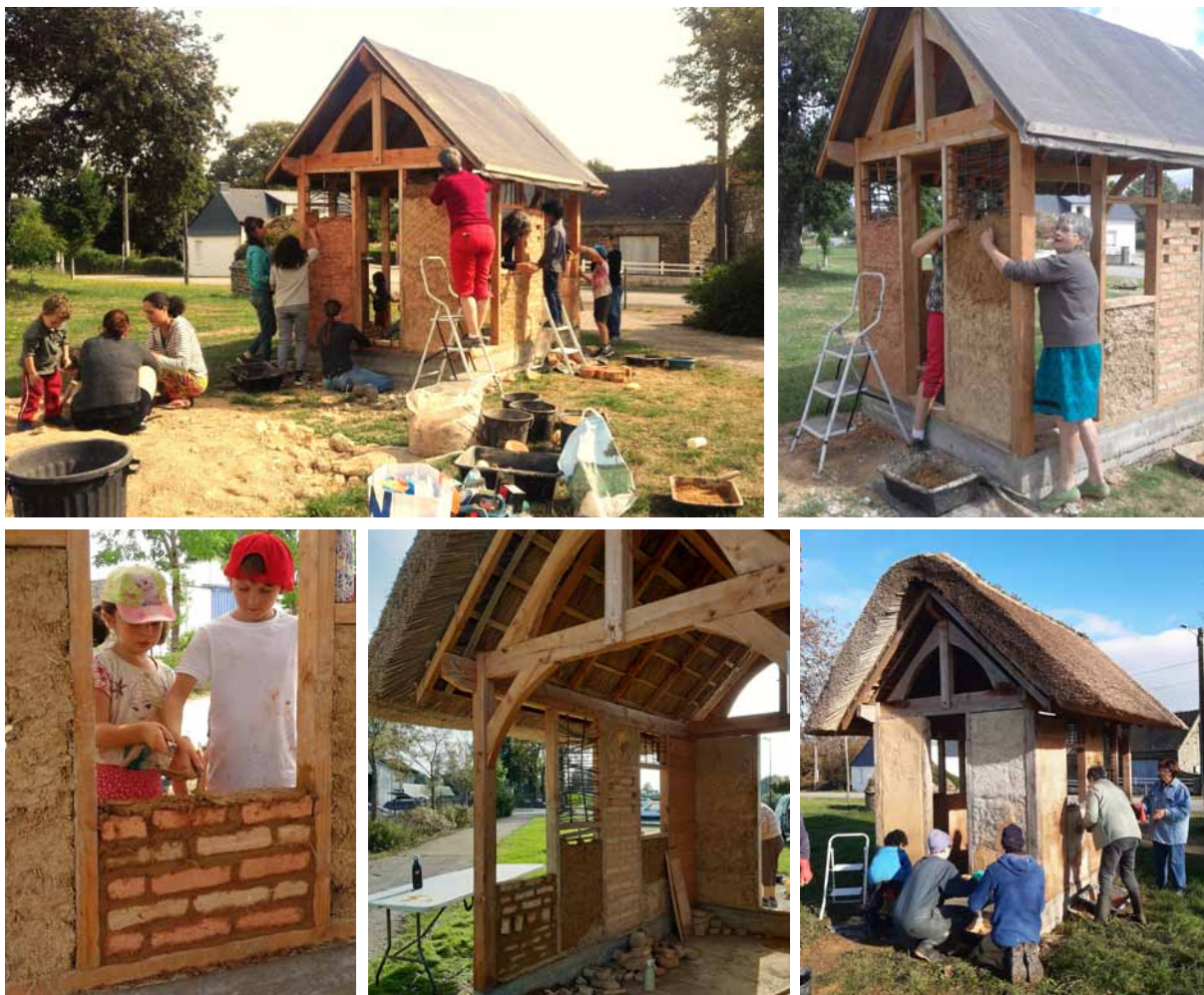
Chantier terre sur la Cabane solidaire à Malansac
