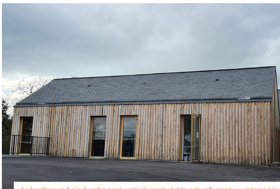
Le bardage en bois douglas posé verticalement résiste naturellement aux intempéries
