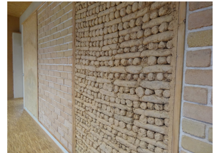
Les murs de parement en briques de terre crue, bauge et pisé.
